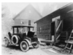
Snímek ukazuje elektrický vůz společnosti Anderson Electric Car Company, která vyráběla na počátku 20. století až 2000 elektromobilů ročně. S příchodem levných a rychlejších aut Henryho Forda prodej rychle klesal, celkově Detroit Electric v období 1907 – 1939 prodal celkem 13 000 elektromobilů.
